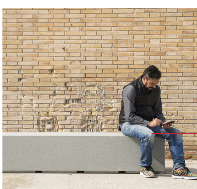
betonový kvádr na sezení
